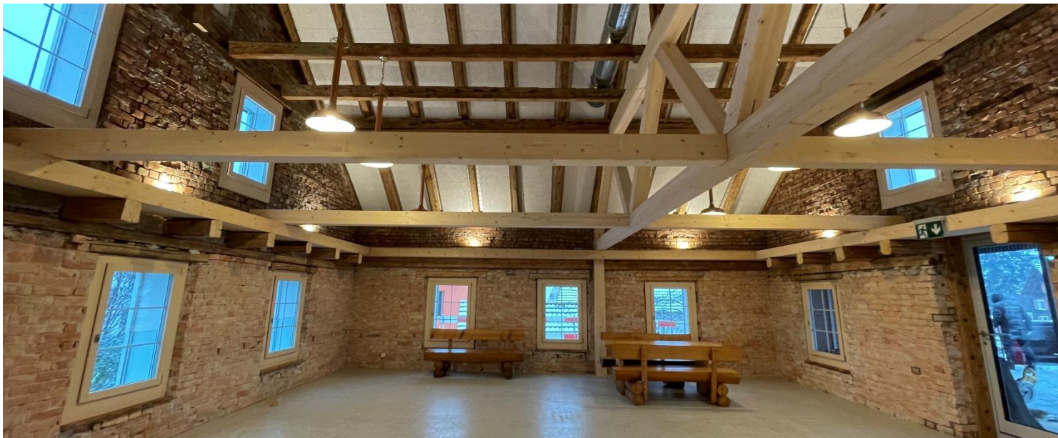
Einbau neuer WC-Anlagen im Obergeschoss
